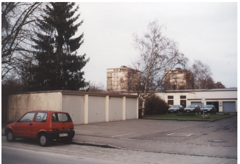
mangelnde Hofgestaltung, hohe Versiegelung
